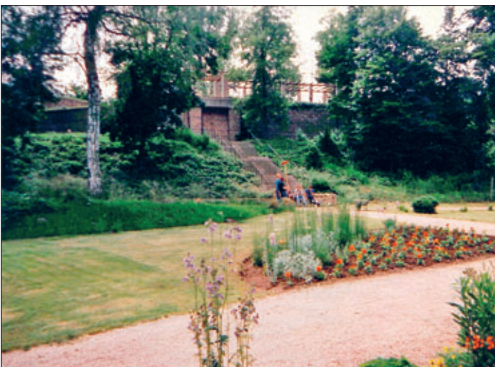
Blick auf die Gabionenwand (Foto: Foto Diettrich)
