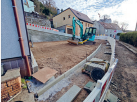
Stützwand Am Park
