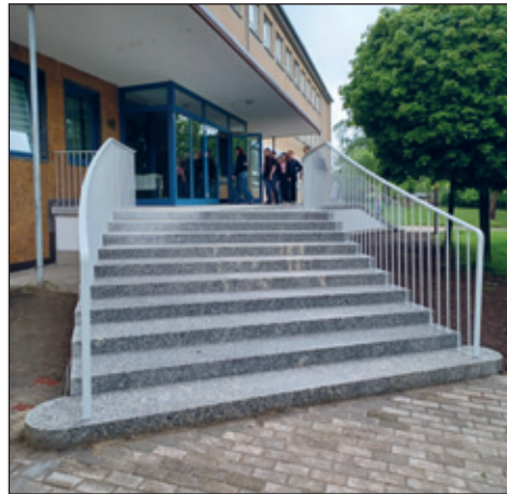
Haupteingangstreppe der Heinrich-von-Kleist-Oberschule
