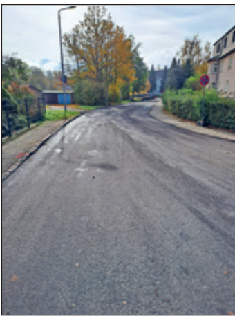
Asphaltdeckeneinbau auf der Rudolf-Breitscheid-Straße im Abschnitt von der Friedrich-Ludwig-Jahn-Straße bis zum Thomas-Müntzer-Weg am 21. Oktober 2024
